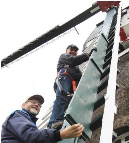
**Bild 2** Entnehmen der Windbretter
