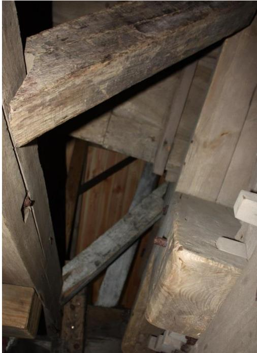
**Bild 7** Eingelegte Sturmbalkensicherung
